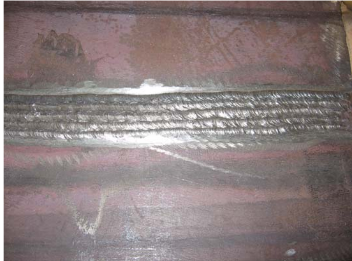
پایان عملیات جوشکاری- قطعه آماده بازرسی چشمی
